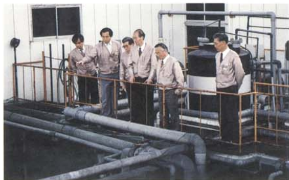
ソニー瑞浪株での排水処理施設の現場監査風景
