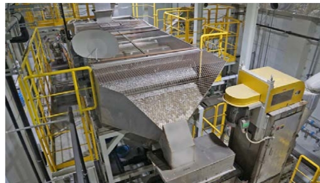
グリーンサイクル株式会社における高純度選別プロセスでの水浮沈選別工程の装置
