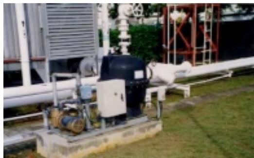
クーリングタワーのクリーニング用水のフィルター/循環・リサイクルシステム
