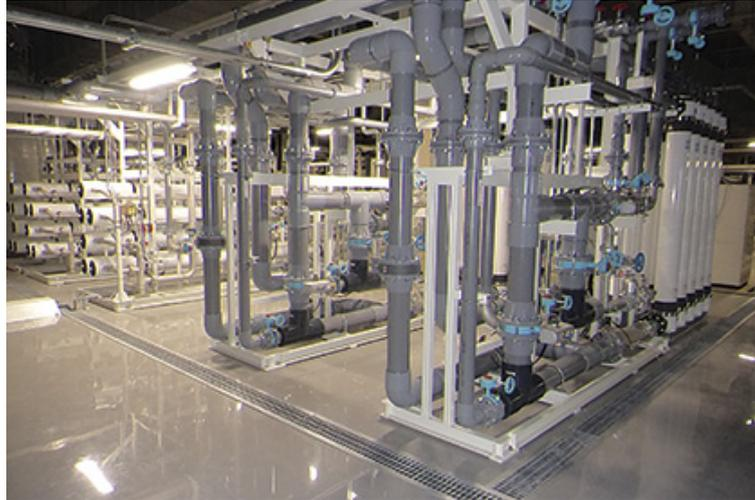
ガス除害装置に導入された排水回収システム
