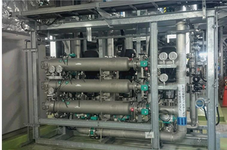
計測器ブロー水を再利用しているRO(逆浸透膜濾過)システム
