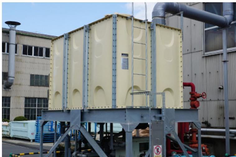
倉庫棟の横に設置された雨水の貯水タンク
